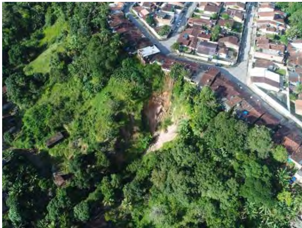
Figura 22.1 Vista aérea do talude a ser contido. Grande erosão na face, presença de casas na crista.
